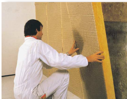
Fachadas con cámara
