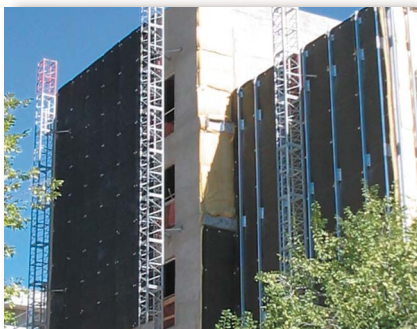
Fachadas con cámara ventilada ISOVER
